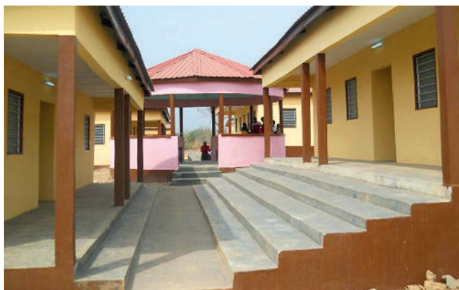
▲ Togo: Einige Gebäude des Blindenzentrums in Kadamba
