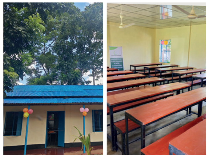
▲ Bangladesh: Fertige Klassenräume von außen und innen
