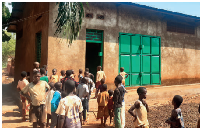
▲ Burundi: Das im Jahr 2011 errichtete Lagerdepot in Rugombo.
