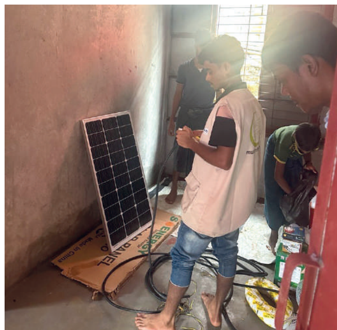
▲ Cox's Bazar, Bangladesch: Arbeiter bei der Installation und Vorbereitung der Solar-systeme für die begünstigten Haushalte in einem Flüchtlingslager.
